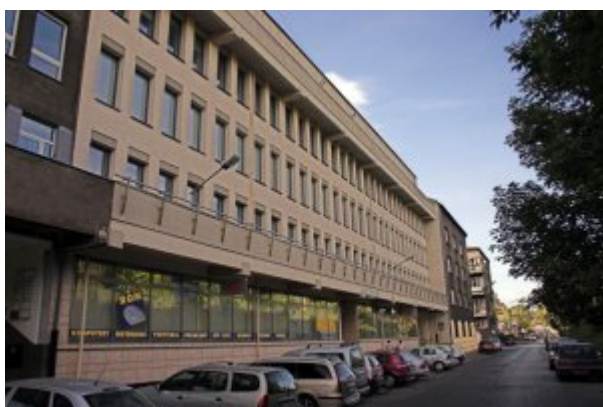
Budynek Oddziału Terenowego
