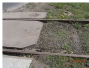
Brak odwodnienia
