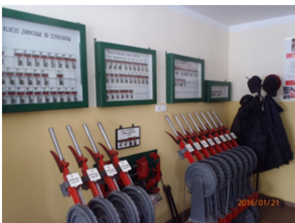
Urządzenia mechaniczne wewnętrzne kluczowe srk
