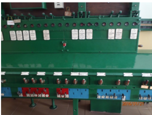
Urządzenia mechaniczne wewnętrzne kluczowe srk
