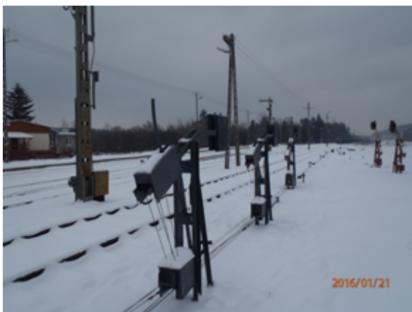
Urządzenia zewnętrzne mechaniczne srk
