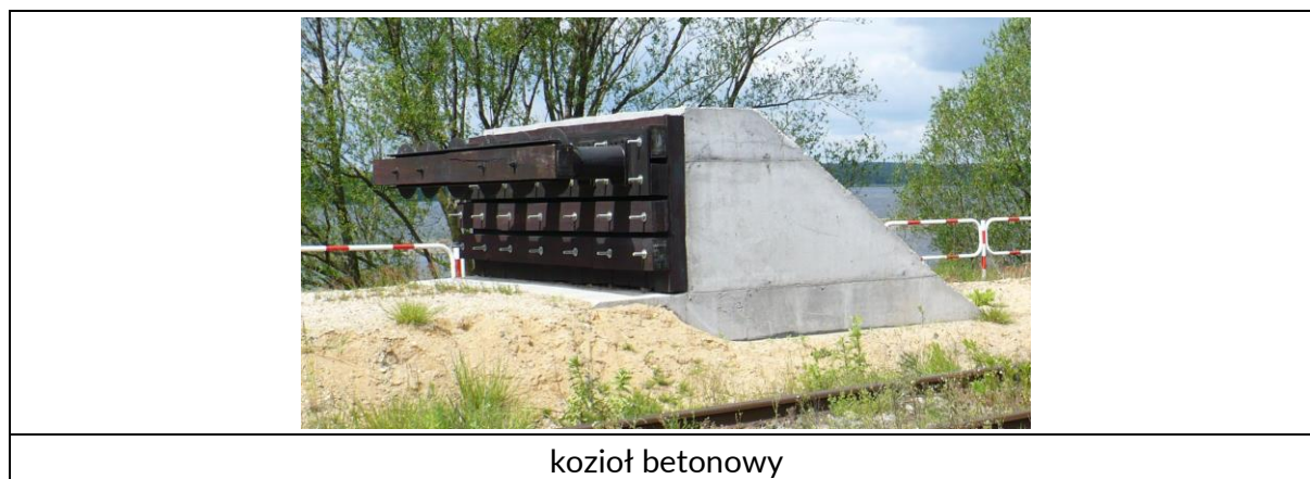
Zdjęcie 17. Kozioł betonowy oraz kozioł samohamujący
