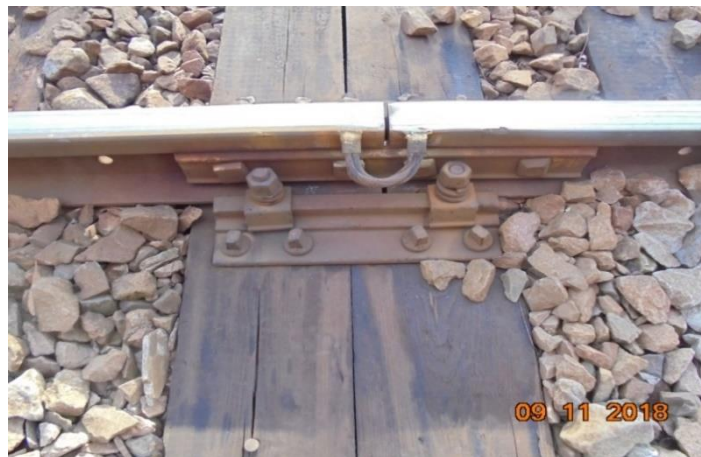
Zdjęcie 81. Miedziany łącznik podłużny spawany
