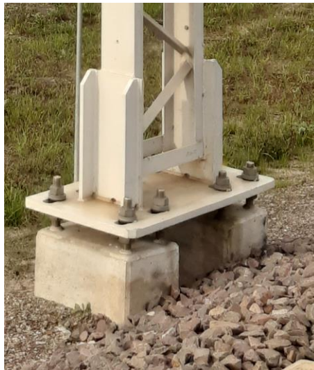
Zdjęcie 76. Słupy bramki ustawione na dwóch palach
