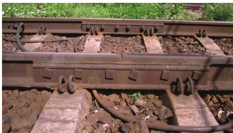
Zdjęcie 13. Złącze izolowane wiszące klejono-sprężone w terenie
