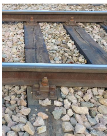
Zdjęcie 4. Przykładowe występowanie w terenie przytwierdzenia pośredniego typu K
