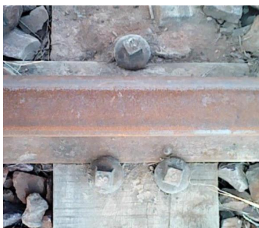
Zdjęcie 3. Przykładowe występowanie przytwierdzenia bezpośredniego w terenie
