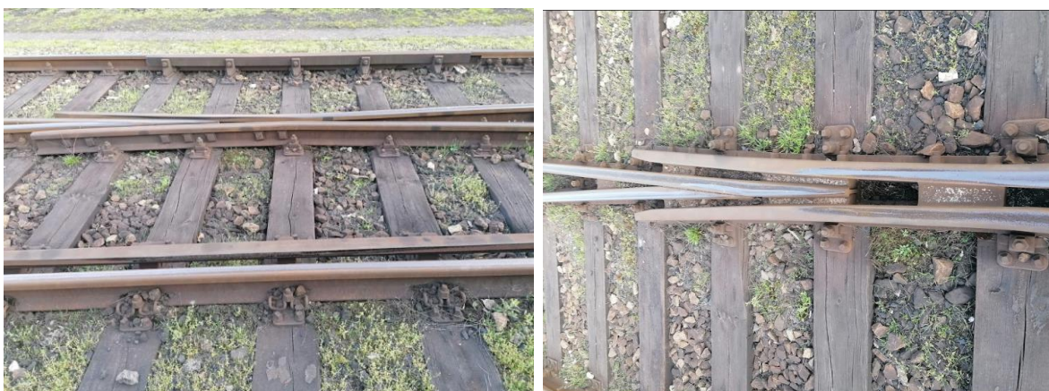
Zdjęcie 46. Przykładowa krzyżownica rozjazdu
