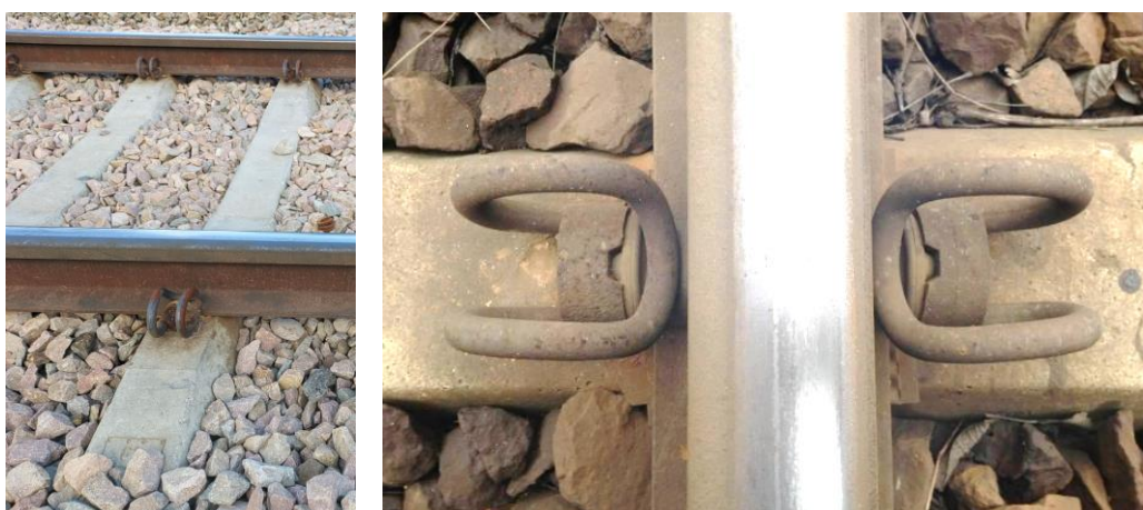
Zdjęcie 6. Przykładowe występowanie przytwierdzenia bezpośredniego sprężystego SB do podkładu betonowego w terenie
