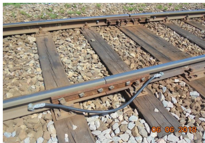
Zdjęcie 82. Łącznik podłużny skręcany
