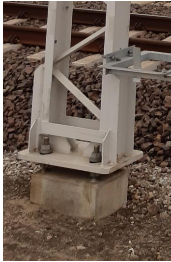
Zdjęcie 75. Posadowienie słupa bramki na jednym fundamencie palowym
