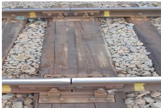
Zdjęcie 83. Oznaczenie miejsca montażu łącznika PP w złączy szynowym
