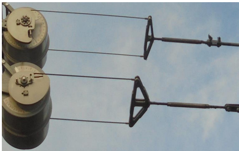
Zdjęcie 62. Kotwienie kompensujące sprężynowe ze sprężynami skrętnymi typu Tensorex C+
