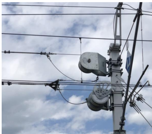
Zdjęcie 60. Kotwienie kompensujące sprężynowe ze sprężynami skrętnymi typu TUN
