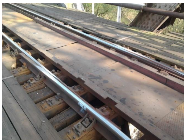
Zdjęcie 22. Przykładowy przyrząd wyrównawczy na moście
