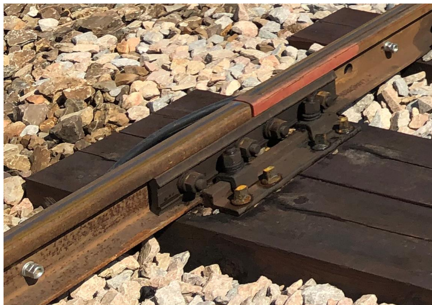
Zdjęcie 11. Złącze podparte nieizolowane w terenie
