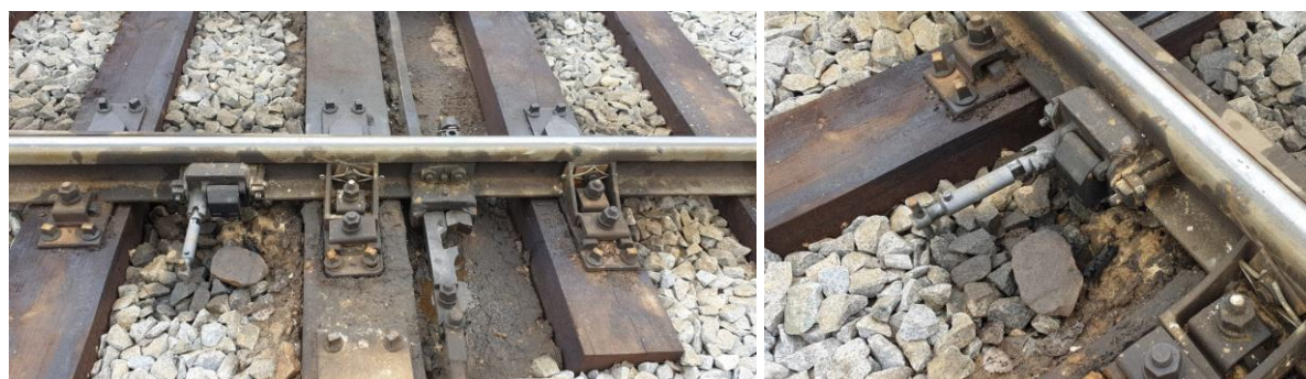
Zdjęcie 52. Przykład zamka trzpieniowego
