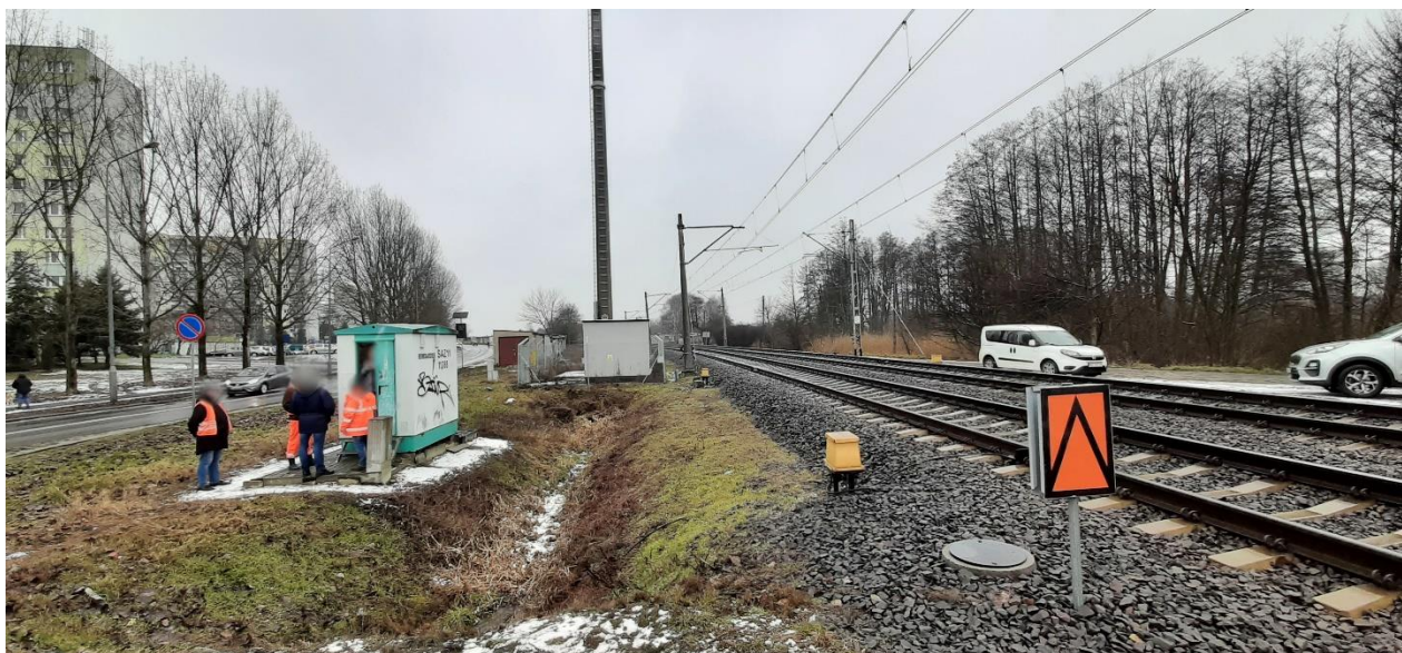
Zdjęcie 6 – Widok na tor nr 2 z drogi z odległości 5 metrów od skrajnej szyny
