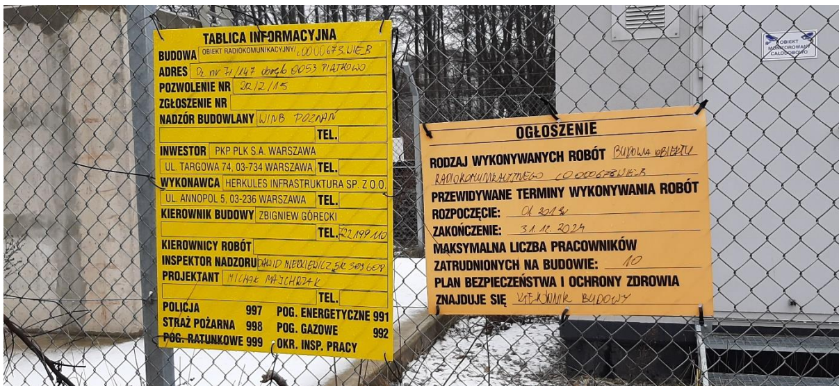
Zdjęcie 8 – Tablice umieszczone na ogrodzeniu obiektu budowlanego
