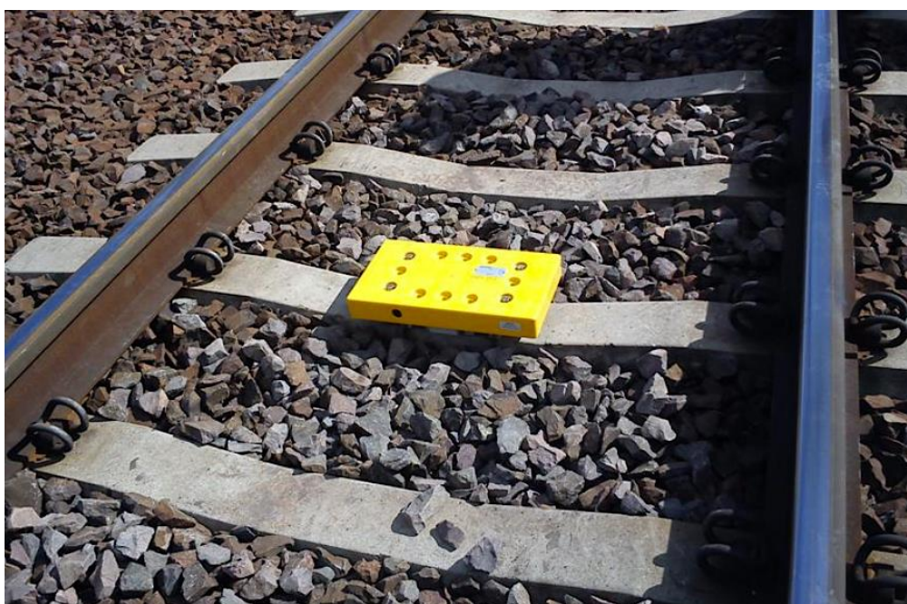
Zdjęcie 55. Eurobalisa zamontowana w torze
