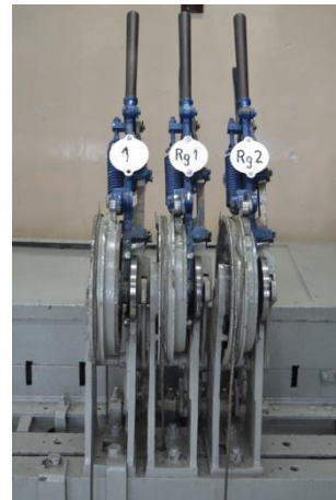
Dźwignie nastawcze na ławie dźwigniowej w nastawni
