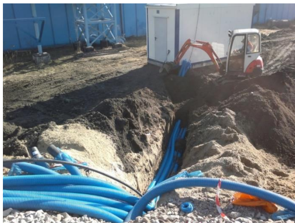
Zdjęcie 73. Przygotowanie kabli do wprowadzenia do kontenera technologicznego srk
