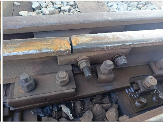
Zdj.2. Wadliwe połączenie.
