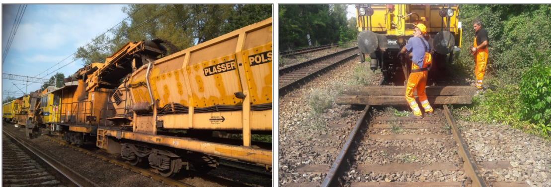
Zdj.9.Oczyszczanie podsypki tłuczniowej oczyszczarką torową RM80. Zdj.10.Wymiana podkładów
