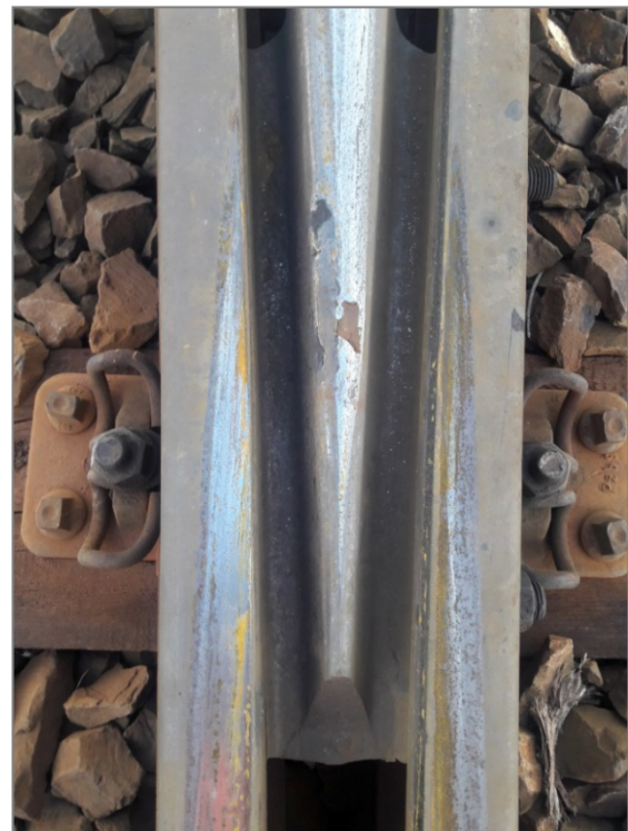
Zdj.2. Wadliwe połączenie.
