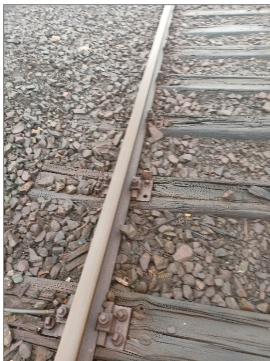
Zdj.5. Boczne zużycie główki szyny w rozjeździe
