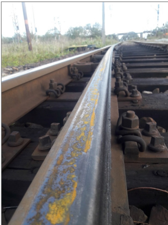
Zdj.5. Boczne zużycie główki szyny w rozjeździe
