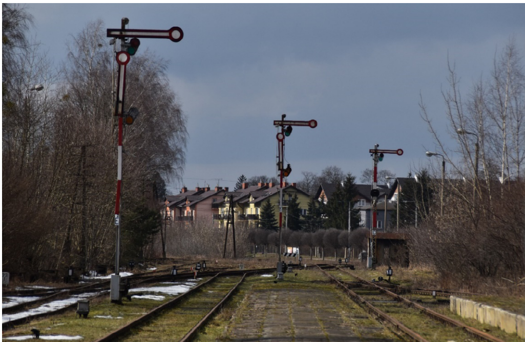
Rysunek 9 Semafony kształtowe wyjazdowe na stacji Lidzbark – widok w kierunku Brodnicy
