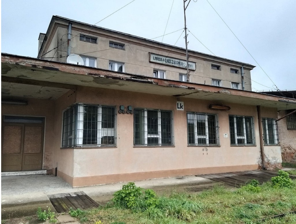
Rysunek 8 Budynek dworca z nastawnią dysponującą Lk stacji Lidzbark
