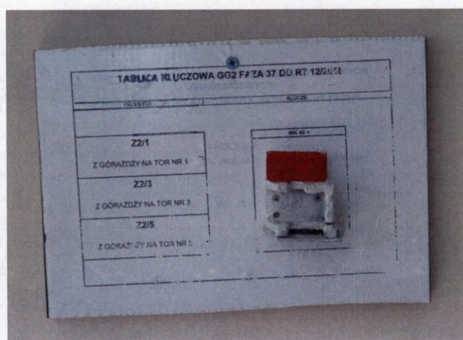
Zdjęcie 5 – Tablica kluczy czynnych nastawni Gg2 wykonana po zaistnieniu incydentu (w czasie trwania kolejnej fazy robót)
