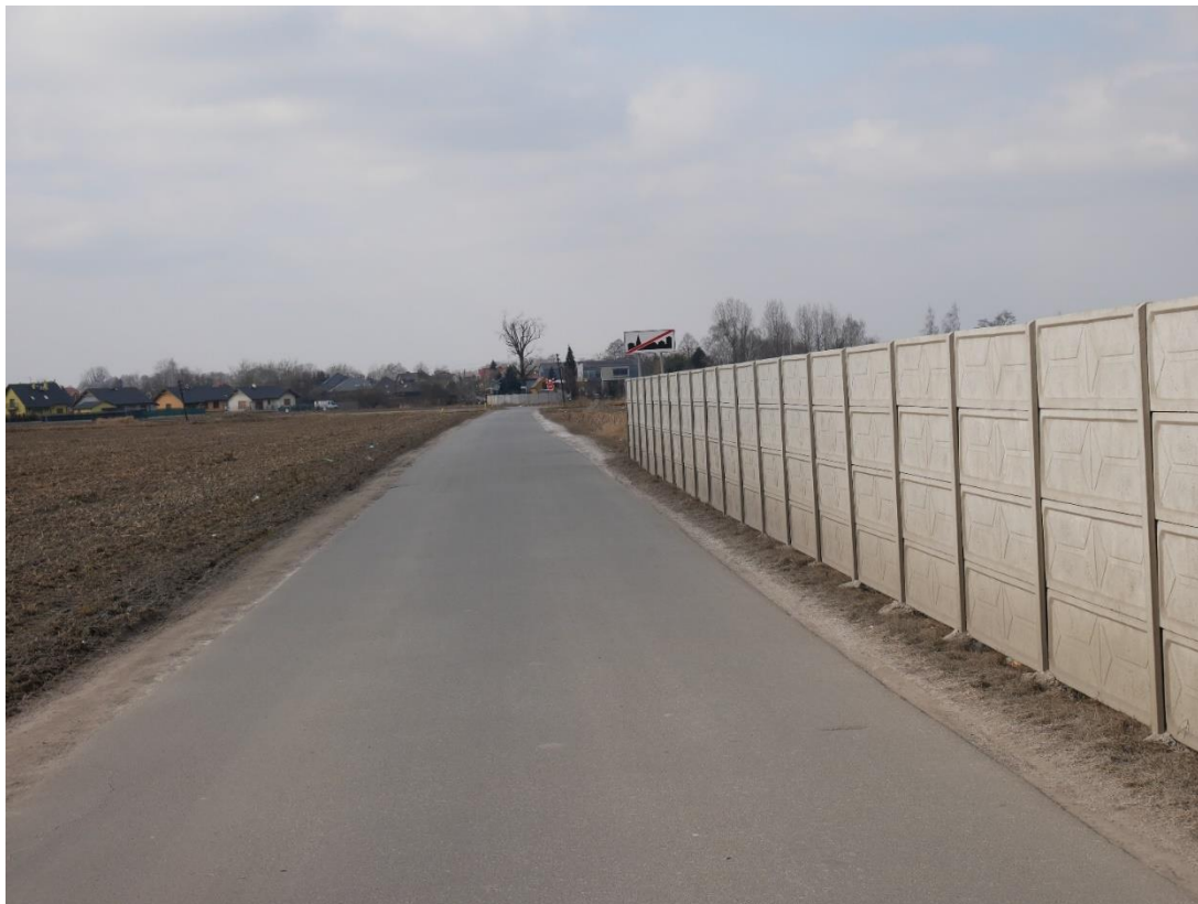
Fot. 8. Oznakowanie przejazdu z kierunku jazdy samochodu (brak znaków A10, G1a, G1b, G1c)
