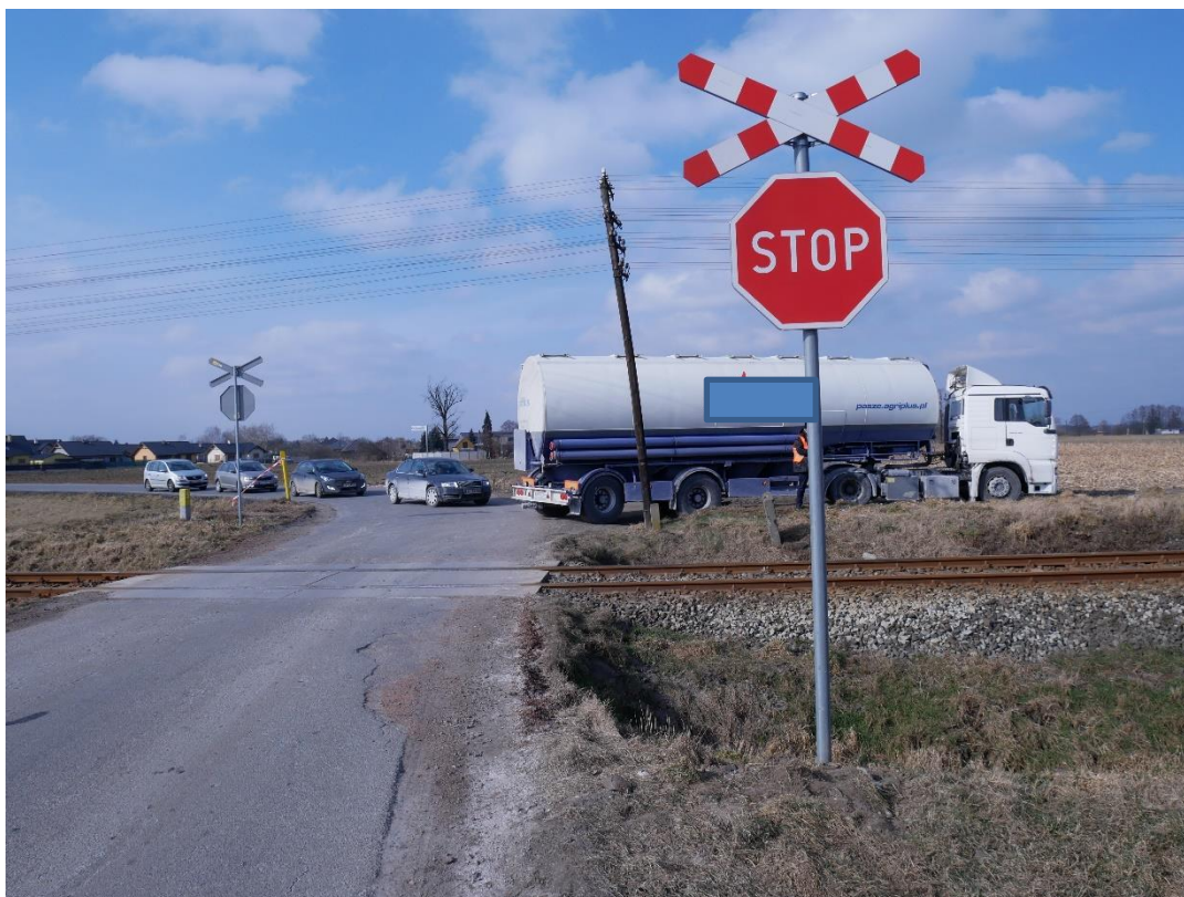
Fot. 11. Droga gruntowa z prawej strony przejazdu, po której poruszają się samochody ciężarowe
