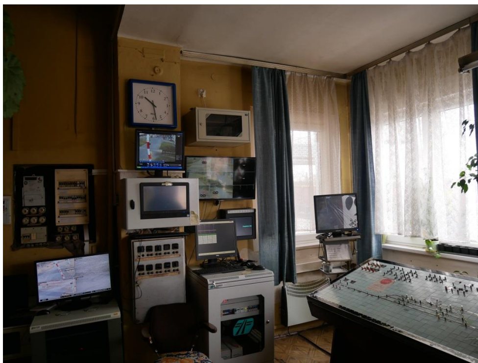
Fot.29. Monitory TVu umieszczone z lewej strony pulpitu w tylnej części pomieszczenia dyżurnego ruchu stacji Ozimek (zabudowane po poważnym wypadku dnia 20.11.2017r.)
