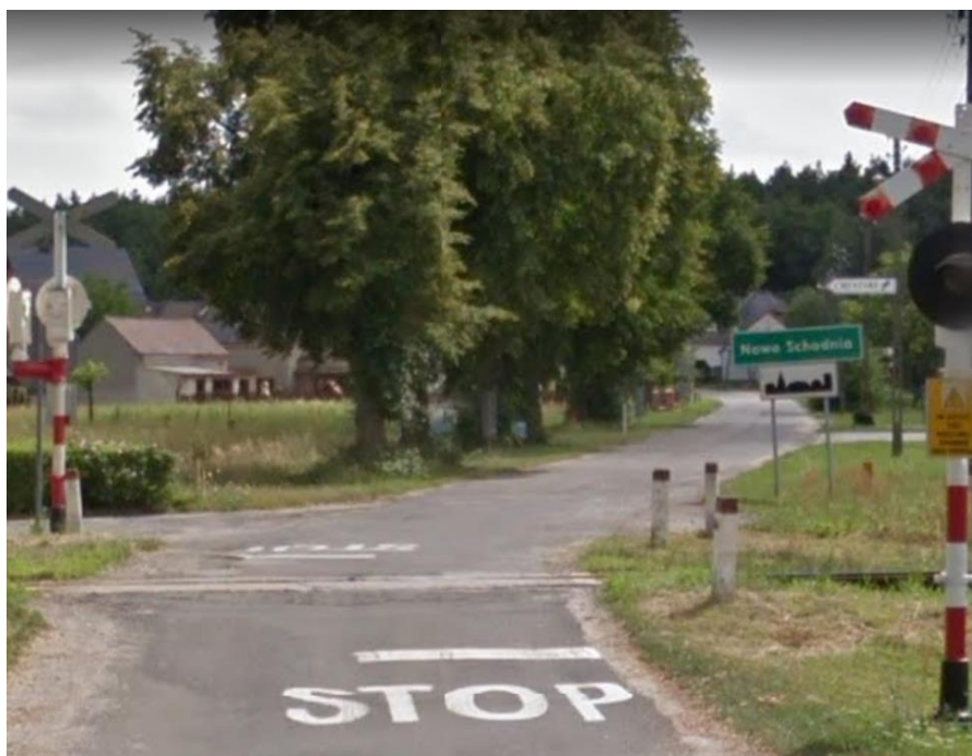
Fot. 18. Widok przejazdu przed rewitalizacją (lipiec 2012r, źródło Internet Mapy Google)
